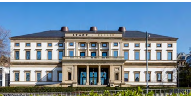
Das Stuttgarter Palais Wilhelm, umgebaut zum Stadtmuseum. Im 1. OG wird die ständige Ausstellung Stuttgarter Stadtgeschichte(n) auf 900 m 2 präsentiert. Die 500 m 2 Fläche im 2. OG steht für Sonderausstellungen zur Verfügung. Im Gartengeschöß befindet sich die Mitmachausstellung BauMit. Foto: Museum
